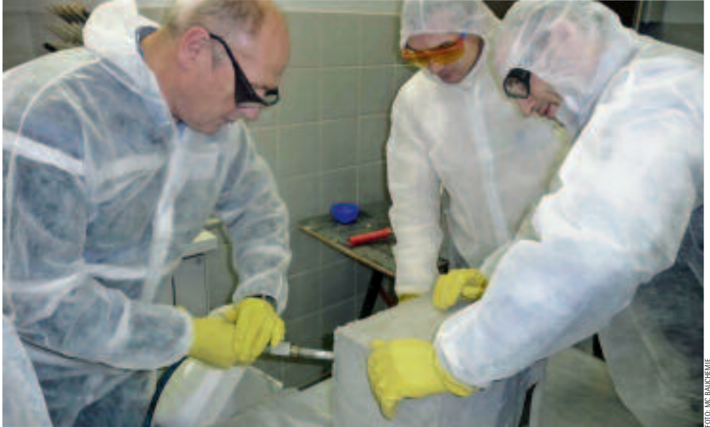
Russische Verarbeiter von MC Bauchemie üben im Rahmen ihrer Ausbildung an einem Betonwürfel eine Rissinjektion .
